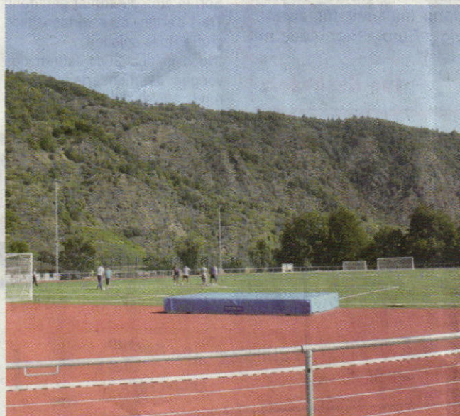
Nach nur fünf Monaten Bauzeit können sich die heimischen Sportler über eine neue und hochmoderne Sportstätte freuen.
